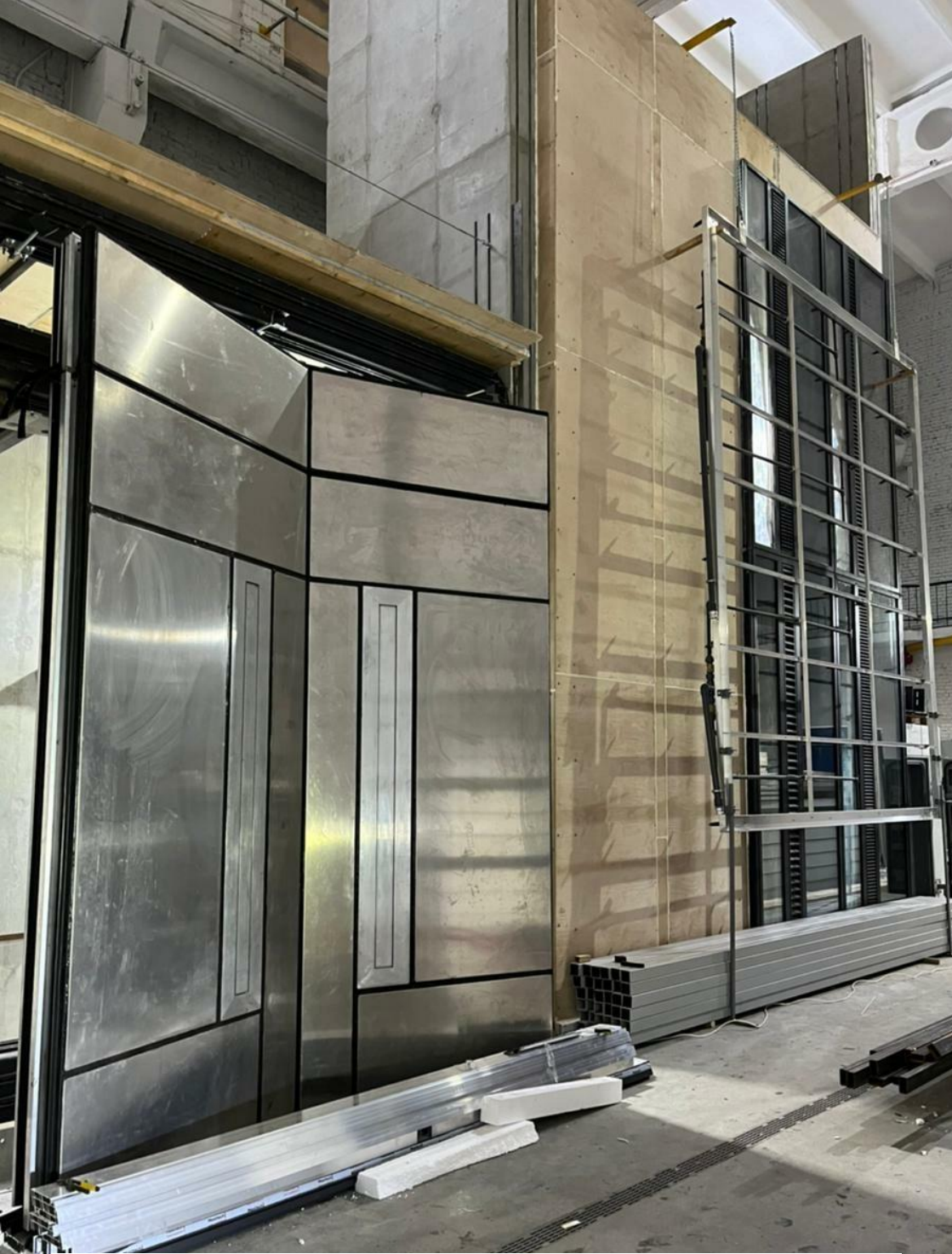
НОВАЯ ИСПЫТАТЕЛЬНАЯ УСТАНОВКА НИИСФ РААСН ДЛЯ ОЦЕНКИ ВОЗДУХО- И ВОДОПРОНИЦАЕМОСТИ ОБОЛОЧКИ ЗДАНИЯ
