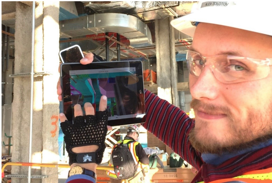
Рисунок 9. Связь прямо со стройплощадки с моделью в «облаке» – для некоторых это уже реальная строительная практика
